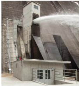
【発電設備の新設・増強】
