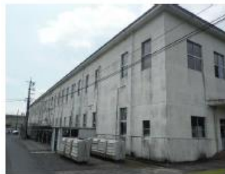
【現状施設の例(庁舎)】
